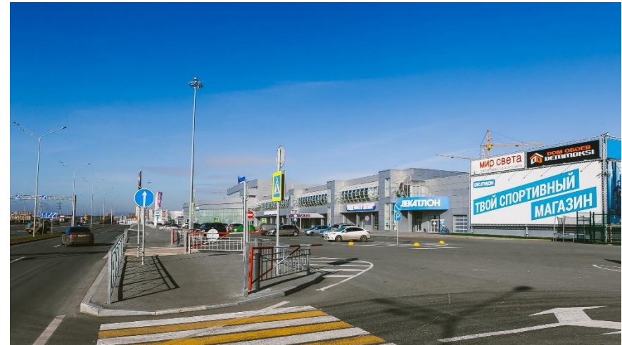
Фасад А сторона
